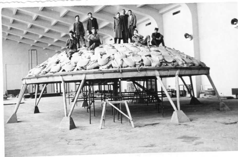
Sl.11.- Model pod opterećenjem p = 200 \text{ kg/m}^2
