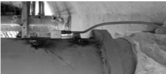
Hình 2. Lắp đặt thiết bị lên thanh chống thép
