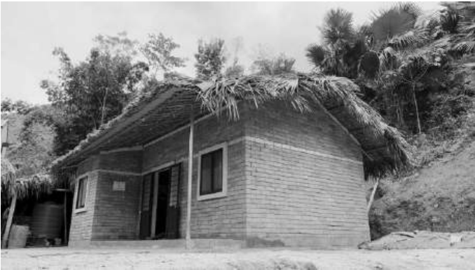
Hình 4. Ngôi nhà đất dành cho DTTS có nhà đất truyền thống được nhóm nhà khoa học do PGS.TS Nguyễn Trung Hiếu, Trường Đại học Xây dựng Hà Nội chủ trì nghiên cứu xây dựng bằng tường gạch đất đỏ, mái lợp lá cọ là các loại vật liệu khai thác tại chỗ, thân thiện với môi trường tự nhiên [17]
