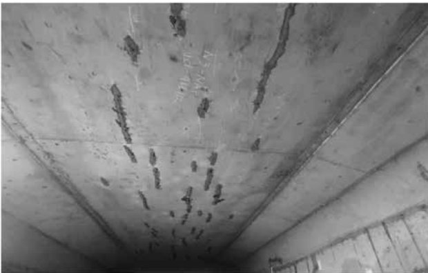
Hình 1. Nứt bản mặt cầu Quán Hàu
