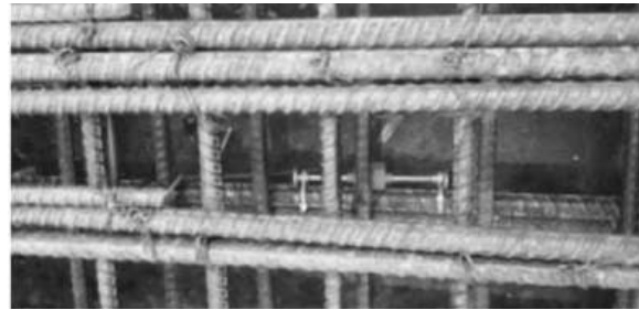
Hình 3. Lắp đặt thiết bị chôn trong bê tông
