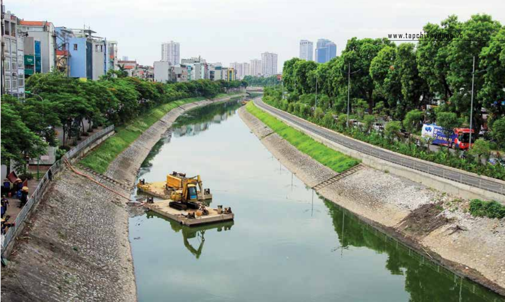
Công tác thi công nạo vét bùn sông Tô Lịch do Công ty TNHH MTV Thoát nước Hà Nội thực hiện.
