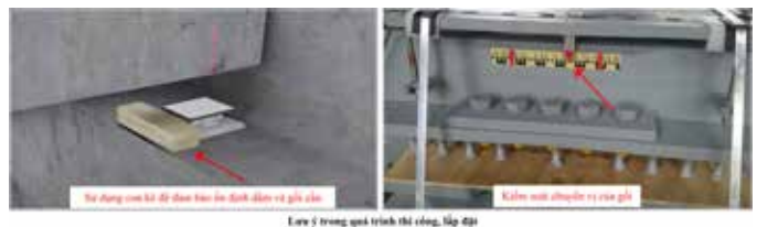
Hình 8. Kiểm soát sự ổn định và chuyển vị của gối trong quá trình thi công lắp đặt.
