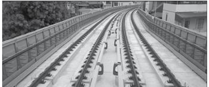
Hình 2. Khổ đường ray 1.435 mm dùng cho đường sắt đô thị tuyến Cát Linh - Hà đông [6]
