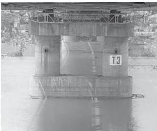
Hình 4. Trụ T3 và gắn cảm biến trên trụ
