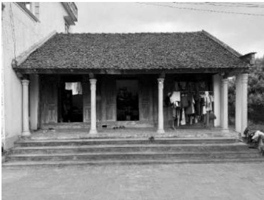
Hình 12. Nhà gỗ đã cải tạo tường gạch, xây thêm nhà mới
