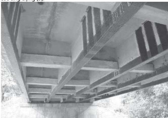
Hình 2. Sử dụng CFRP gia cường kết cấu cầu trên quốc lộ 70 [3]
