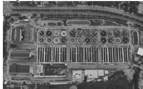
Hình 1. Dự án xây dựng hệ thống thu gom Nhà máy XLNT Yên Xá.
