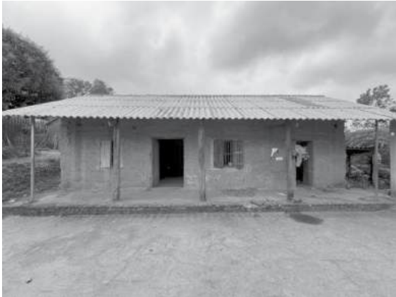
Hình 9. Nhà ở dân tộc Tày đã được cải tạo lại mái nhà
