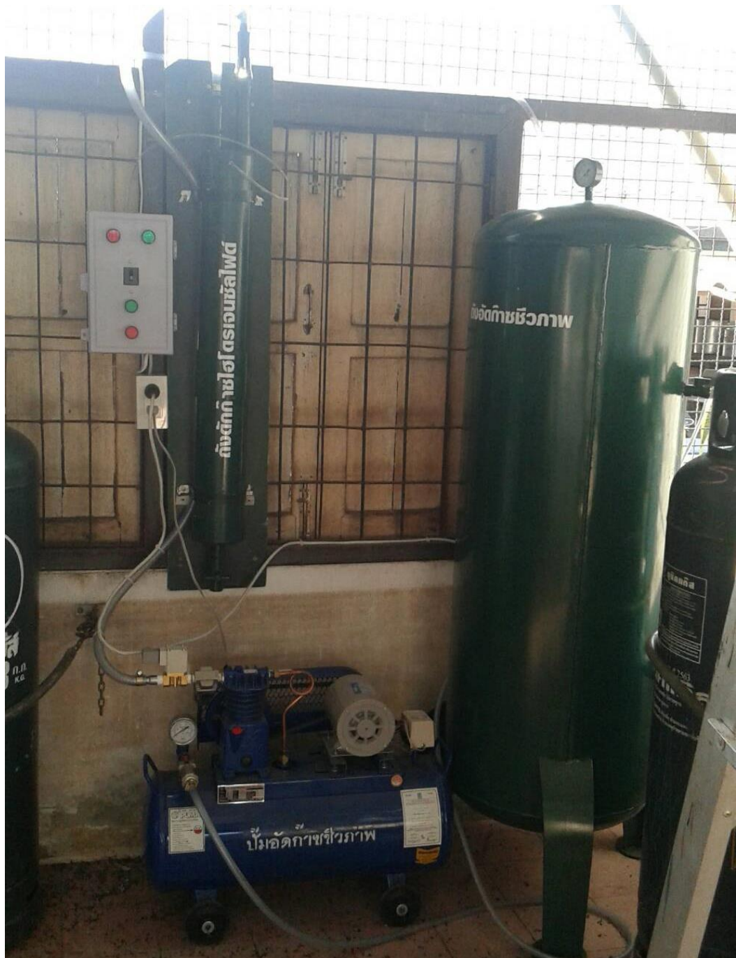
รูปที่ ๒.๓ การติดตั้งอุปกรณ์ของระบบผลิตก๊าซชีวภาพที่ต้องติดตั้งในที่ร่มได้ขยายคา
