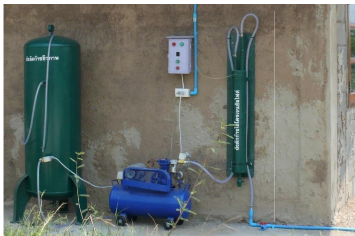
รูปที่ ๒.๗ การเดินท่อเชื่อมต่อระหว่างถังดักน้ำและถังดักก๊าซโซโครเจนซัลไฟด์
