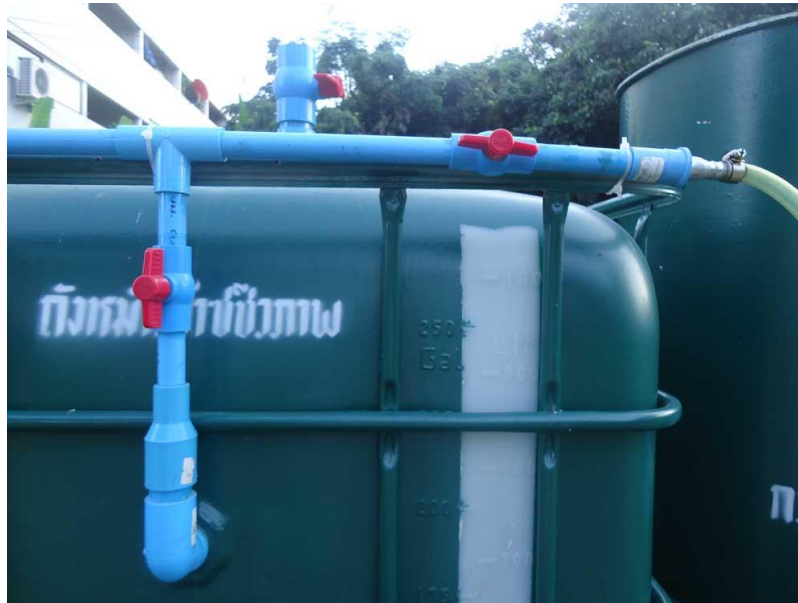
รูปที่ ๒.๔ การต่อท่อส่งก๊าซจากถังหมักก๊าซชีวภาพไปยังถังเก็บก๊าซชีวภาพ
